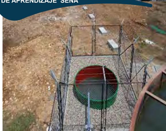
Obra civil para construcción de planta de tratamiento de agua tipo accelapack capacidad 30 I.P.S.
