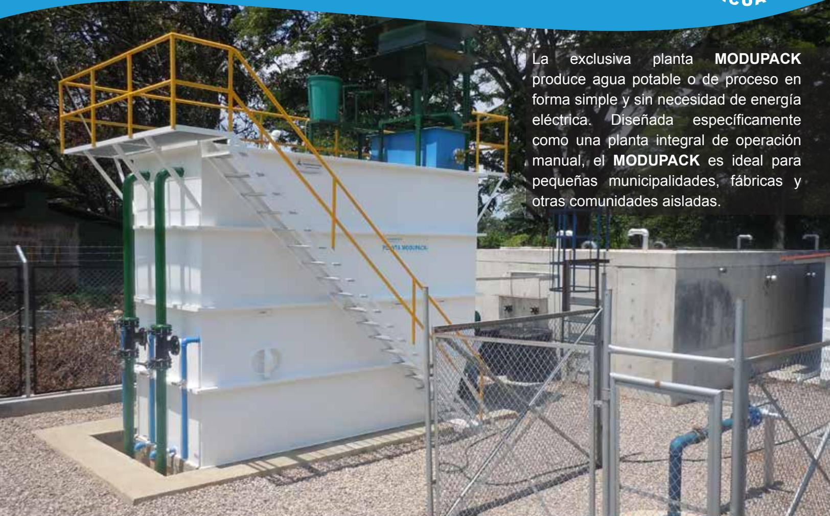
La exclusiva planta **MODUPACK** produce agua potable o de proceso en forma simple y sin necesidad de energía eléctrica. Diseñada específicamente como una planta integral de operación manual, el **MODUPACK** es ideal para pequeñas municipalidades, fábricas y otras comunidades aisladas.
