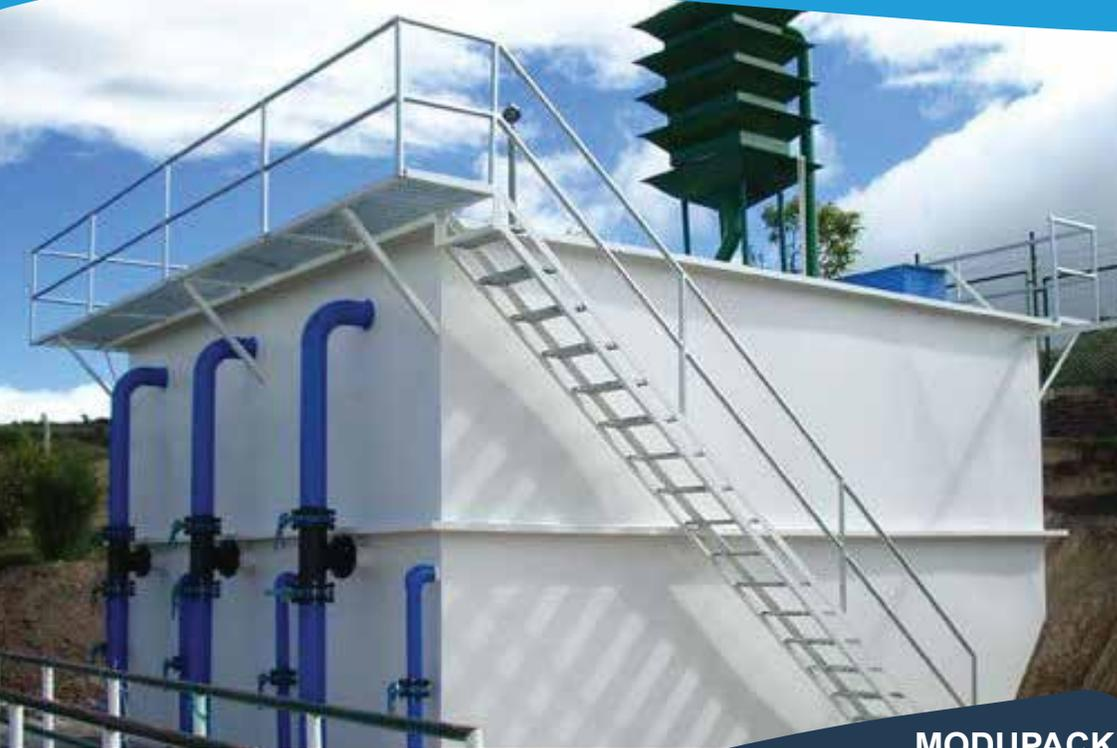
**TECNOLOGÍA DE PUNTA CICLO COMPLETO “RAS” QUE INCLUYE TODOS LOS PROCESOS: ADICIÓN DE QUÍMICOS, MEZCLA RÁPIDA, FLOCULACIÓN, SEDIMENTACIÓN, FILTRACIÓN Y DESINFECCIÓN.**
