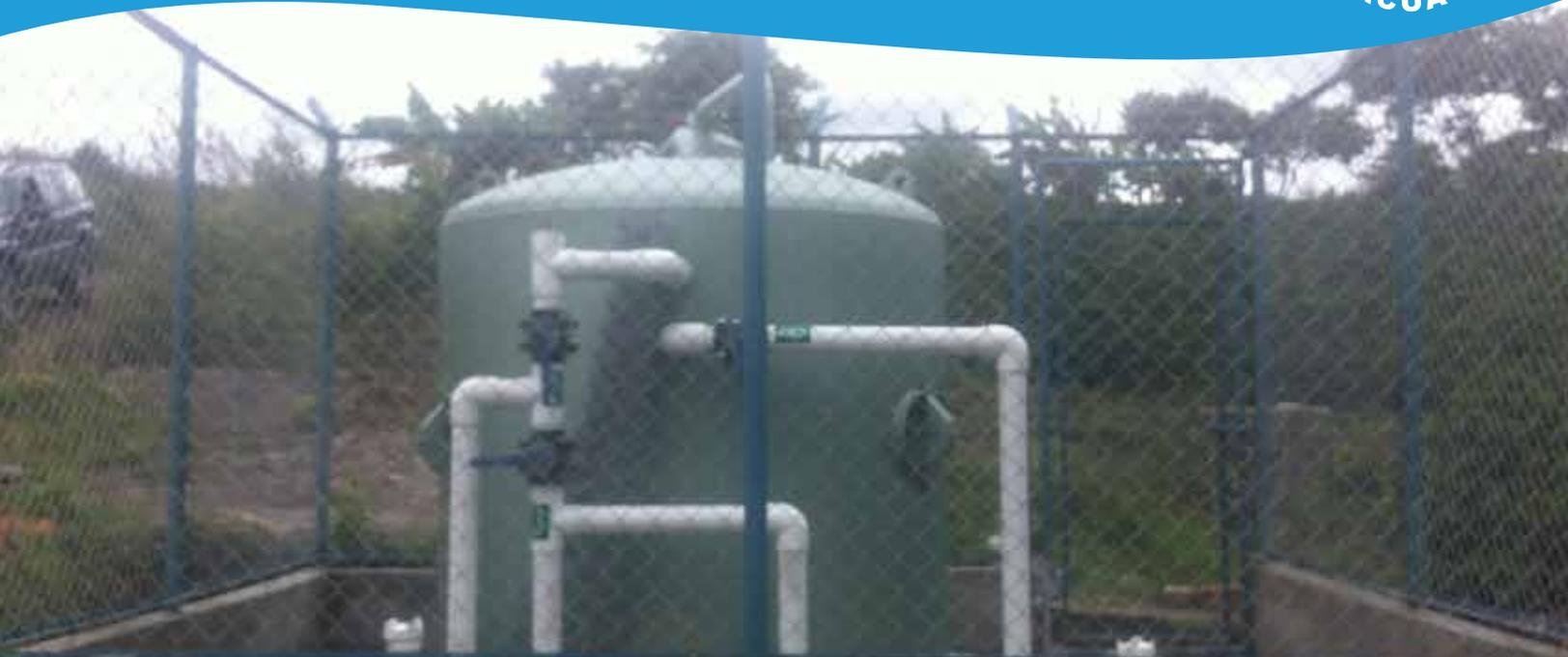
El MINIPACK se recomienda para aguas con turbiedad no mayor a 50 UNT o caudales entre 1 a 10 L.P.S. Se le puede adicionar torre de oxidación para trabajar aguas con alto contenido de hierro y otros minerales.
